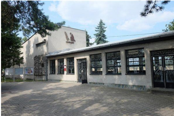
stav domu smútku pred rekonštrukciou
