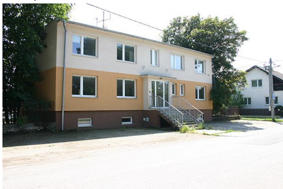
Budova knižnice – budúceho Domu sociálnych služieb pred rekonštrukciou
