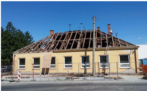
stav budovy mestského úradu – budúcej knižnice pred rekonštrukciou
